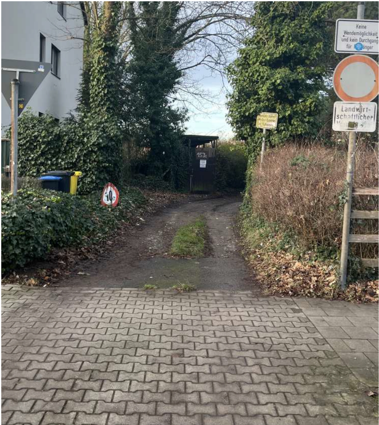
Zugang zum Stichweg von der Volmerswerther Str. Höhe Hausnr. 155.
