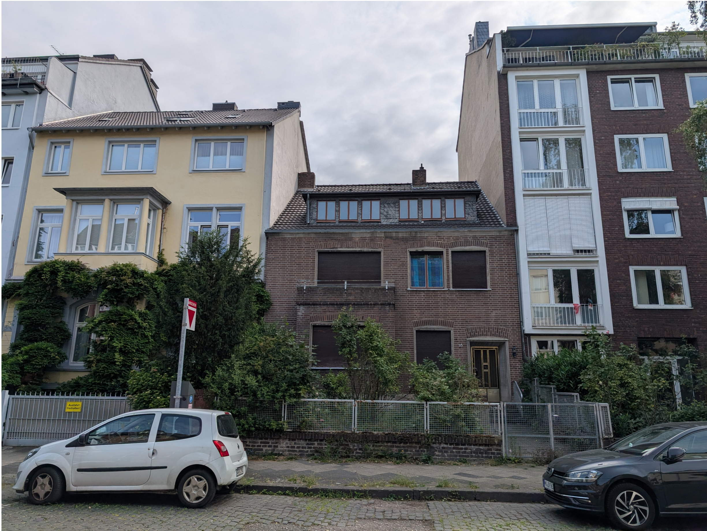
Foto Bestand, Ansicht Straßenseite
