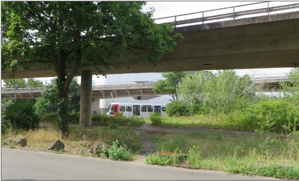
Abbildung 9: B7-Brücken mit U75 auf Pariser Str. (Blickrichtung: Süden)
