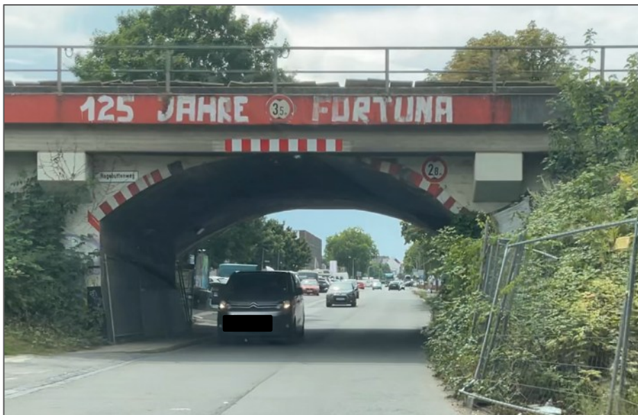
Abbildung 55 – Bahnbrücke Ronsdorfer Straße (Blickrichtung: Süden)
