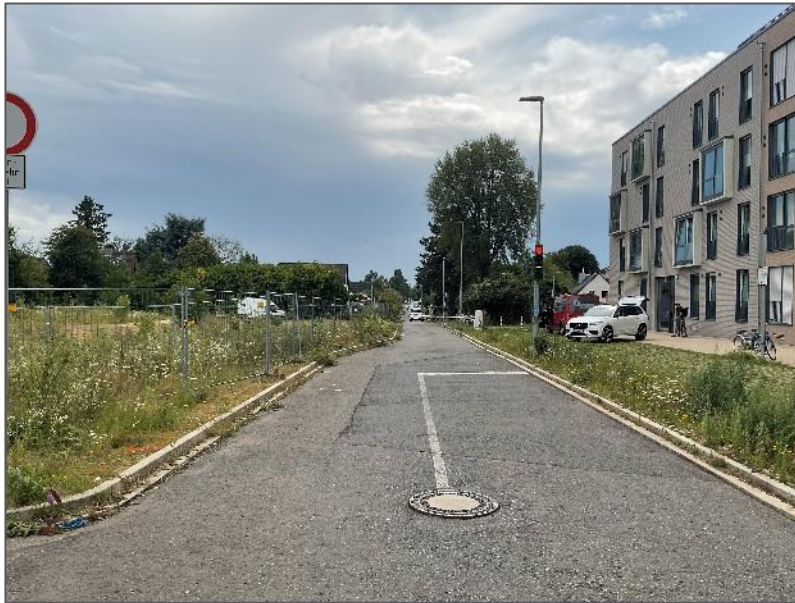
Abbildung 52 – Schrankenanlage Walter-Eucken-Straße (Blickrichtung: Süden)
