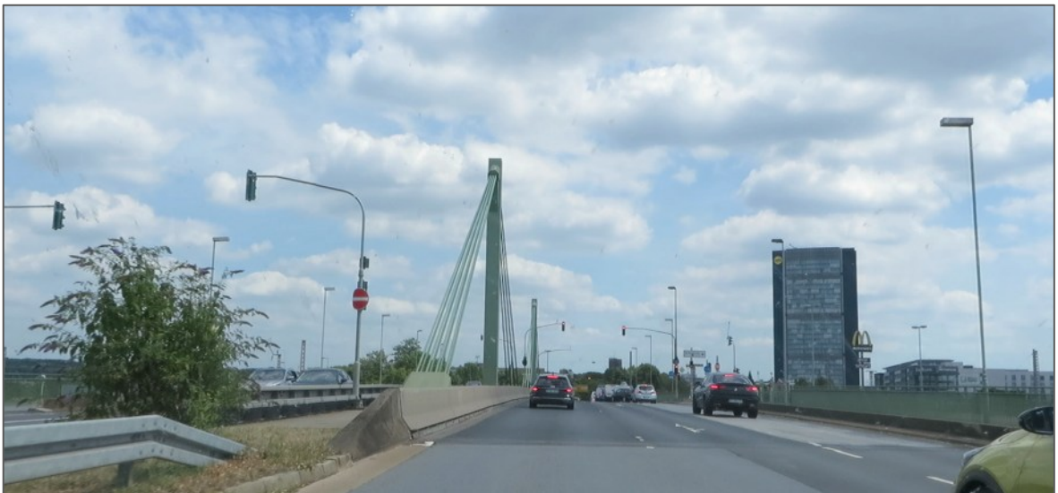
Abbildung 29: Bestehendes Brückenbauwerk über DB-Trasse (Blickrichtung: Osten)
