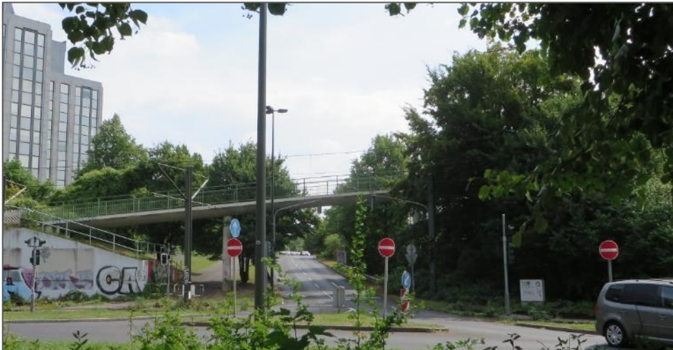
Abbildung 18: Fußgängerbrücke „Am Seestern“
