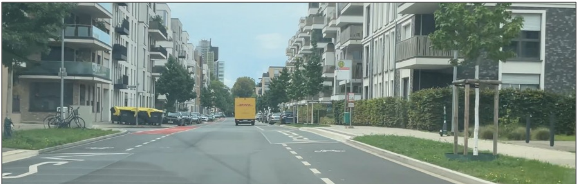
Abbildung 56: Bestandsfahrbahn Hohenzollernallee (Blickrichtung: Westen)
