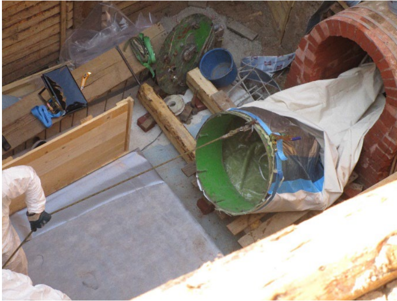
Abbildung 8: Renovierung eines Mauerwerkskanals DN 800/1200 mittels Schlauchlining, lichthärtend
