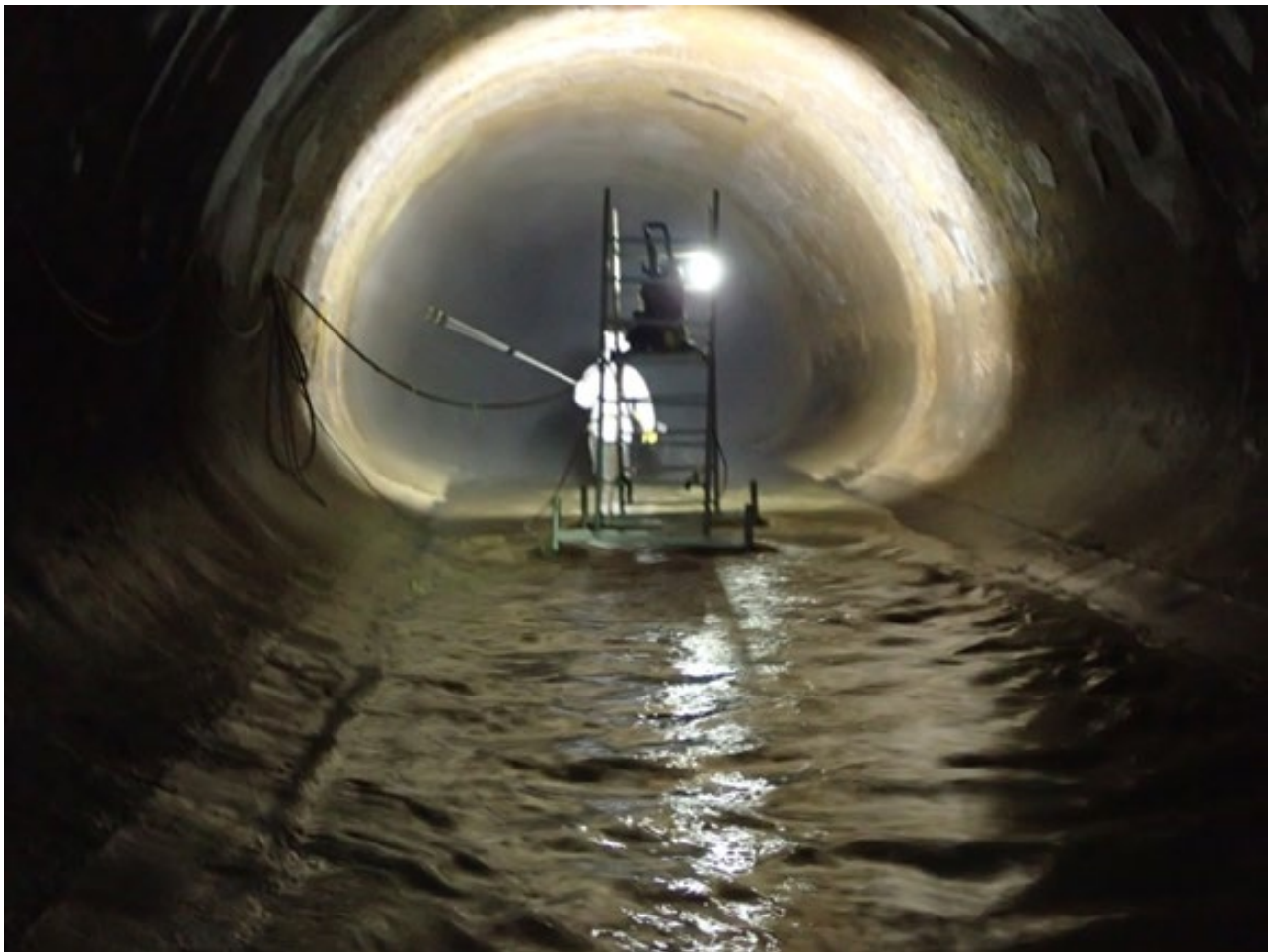
Abbildung 1: Inspektion eines Hauptsammlers
