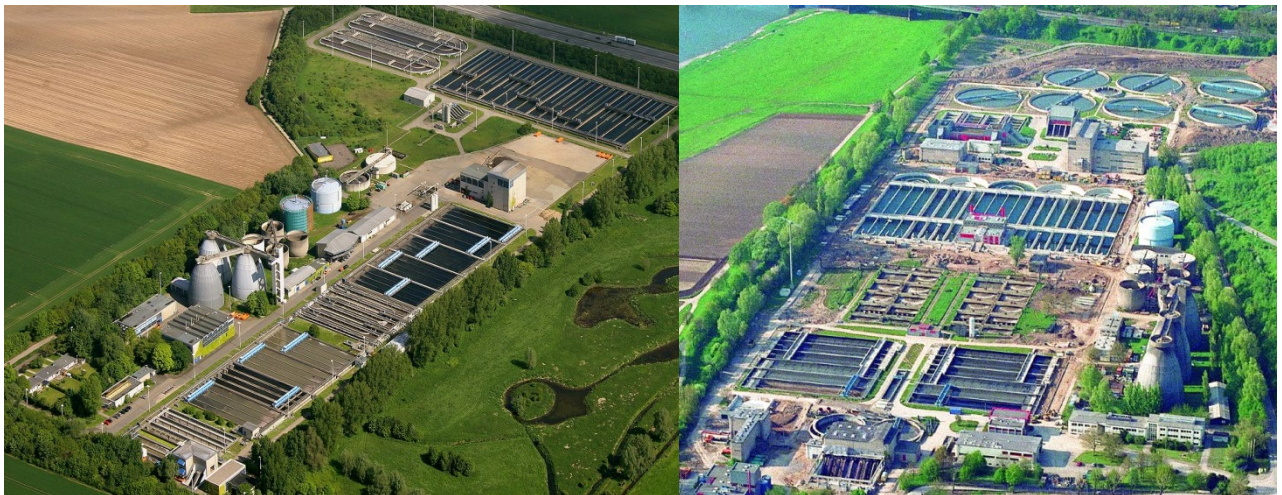
Abbildung 12: Klärwerk Düsseldorf-Nord und Klärwerk Düsseldorf-Süd
