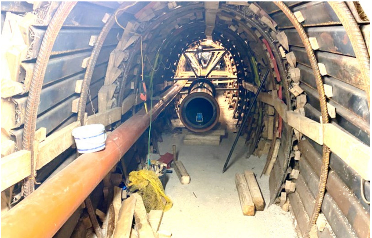
Abbildung 7: Kanalerneuerung mittels bergmännischem Stollenvortrieb
