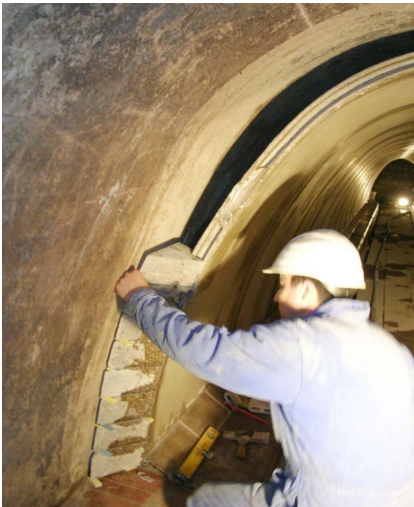
Abbildung 9: Renovierung (Montageverfahren)
