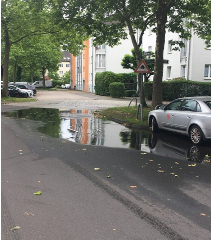
Bild 1: Pfützenbildung auf der Fahrbahn Dresdener Straße
