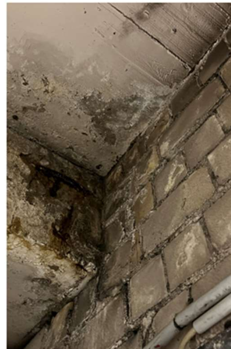
UNDICHTIGKEITEN
