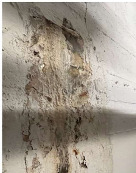
UNDICHTIGKEITEN
